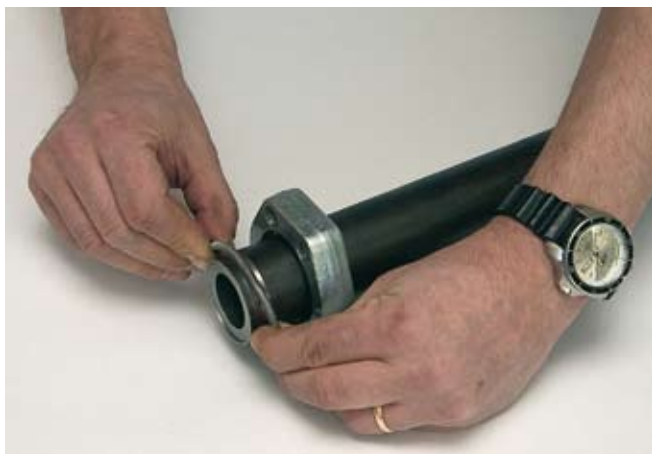
Установите упорное кольцо в канавку на конце трубы.
