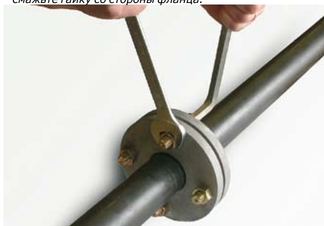
Смазанные болты (и гайки) затягиваются с соответствующим усилием. Процесс монтажа завершен. Стягивайте болты в диагональной последовательности с небольшим возрастающим усилием до достижения соответствующего усилия затяжки. См. картинку слева.
