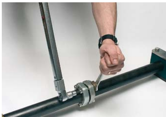
Смазанные болты (и гайки) затягиваются с соответствующим усилием. Процесс монтажа завершен.
